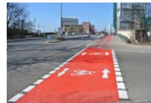
Abb. 188: Radfurt für zwei Richtungen, rot markiert mit Radpiktogrammen und Pfeilen
