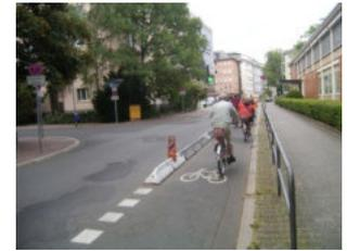
Abb. 196: Sicherheitsabtrennung des Radfahrstreifens von der Fahrbahn
