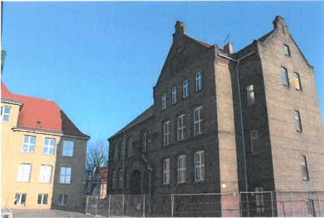
Die Dachzinnen sind in einem sehr schlechten baulichen Zustand und es besteht akute Absturzgefahr. Der Bereich um das Gebäude ist daher seit langem mit Bauzäunen abgesperrt. Diese Absperrung wurde in den letzten Tagen aus Sicherheitsgründen noch weiter in den Schulhof verlegt.
