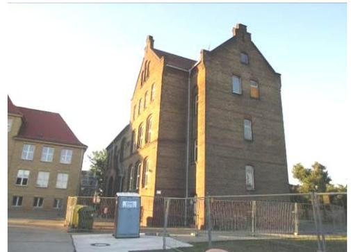
Bei der Sicherung der Bausubstanz ist das 3-reihige Gesims speziell zu sichern. Das Mauerwerk wird verfugt.
