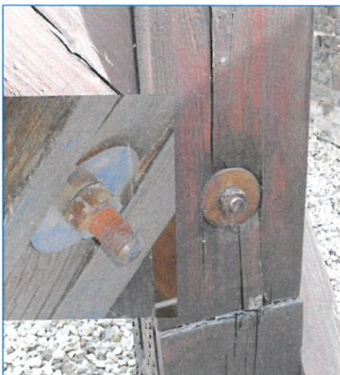
Es ist offensichtlich, dass das Holz im Bereich der Schraubverbindungen verschlissen ist. Ob bereits statische Mängel oder Gefährdungen bestehen, konnte noch nicht geprüft werden.
